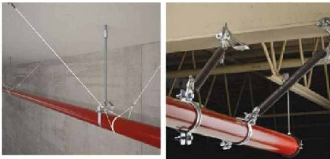
FIG.12 – Esempi di controventi con filo di acciaio e con barre rigide.
